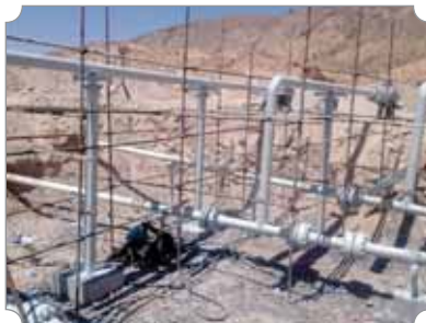
فعالیت مکانیکال تکمیل شده پس از رنگ آمیزی
